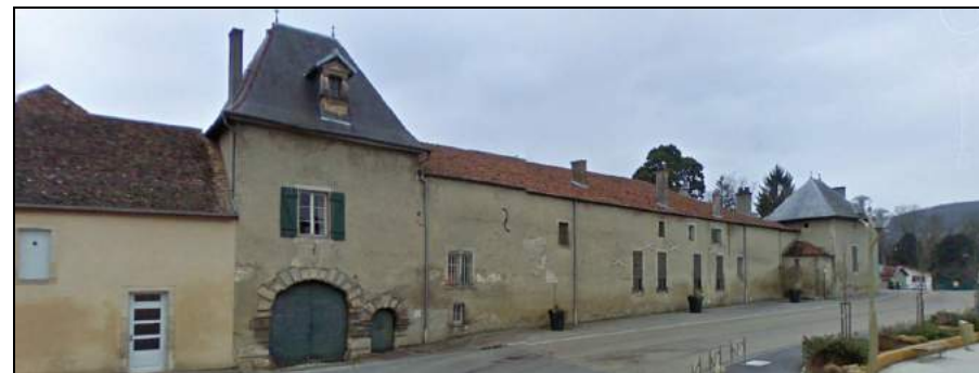
Photo 60 : Château de Poissons (Source : Google Earth)
