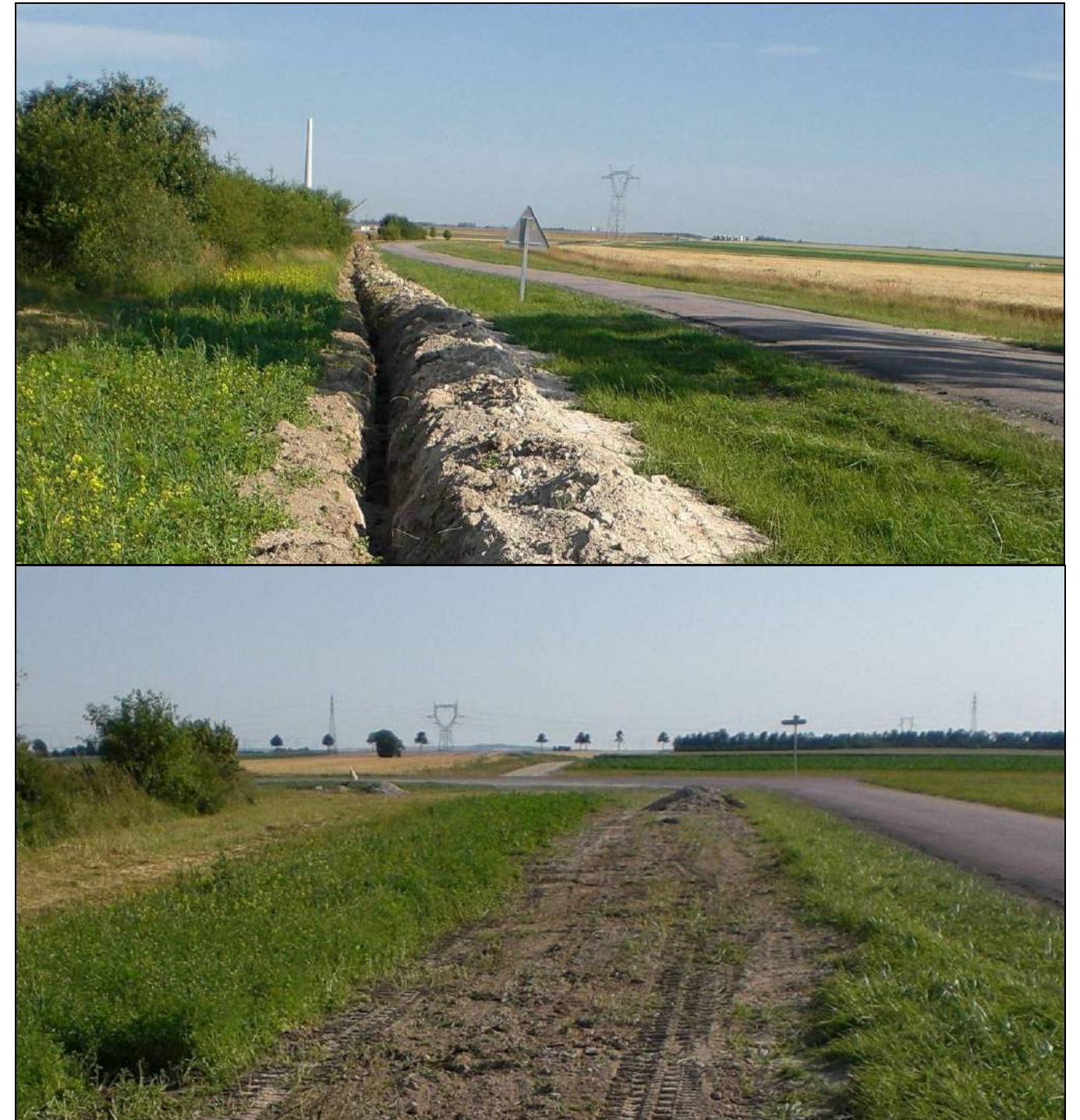
Photo 68 : Rebouchage de tranchée après passage des câbles électriques (Source : BE JC)
